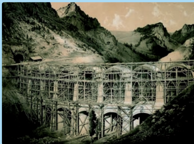
Die Semmeringbahn in Bau
